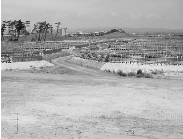
写真 10. 復旧が進む海岸防災林
