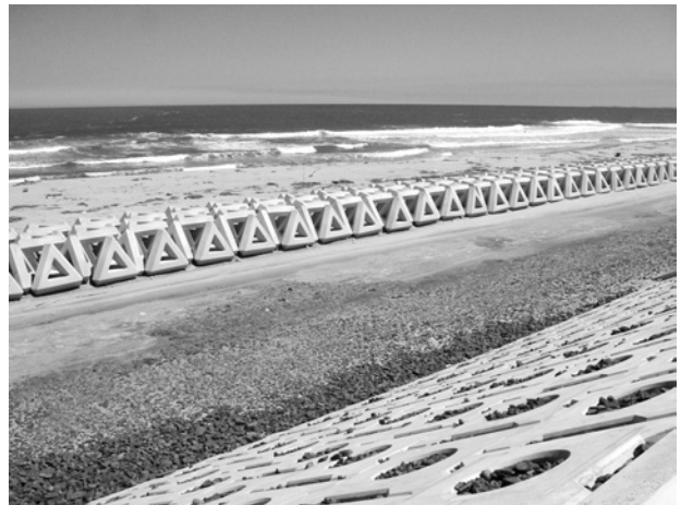
写真 6 砂浜に置かれた消波ブロックと工事用道路 亶理町吉田, N38° 01' 50", E140° 55' 10", 2014 年 7 月 21 日。
