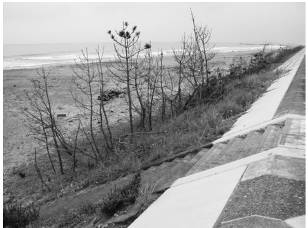
写真 7 既存の砂丘植生に配慮した工法 山元町山寺, N37° 58' 28", E140° 54' 51", 2014 年 6 月 22 日。
