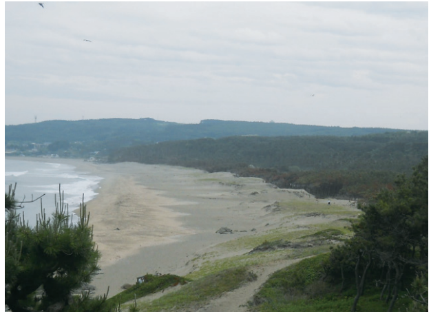
写真 5 津波後の砂丘と枯死したクロマツ(右奥)。その後、枯死したクロマツは伐採された。(大須賀海岸, 2011.6.20)
