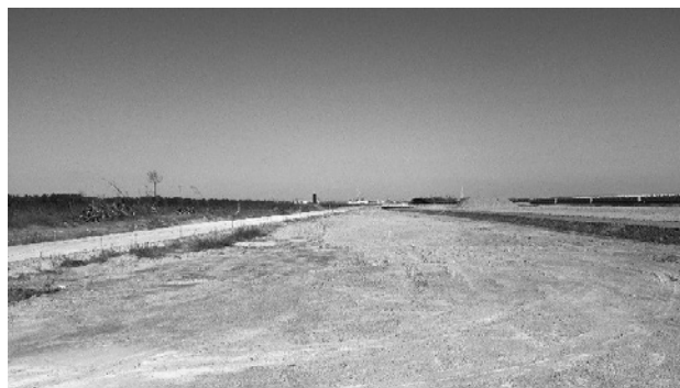
写真 2 防潮堤建設現場
