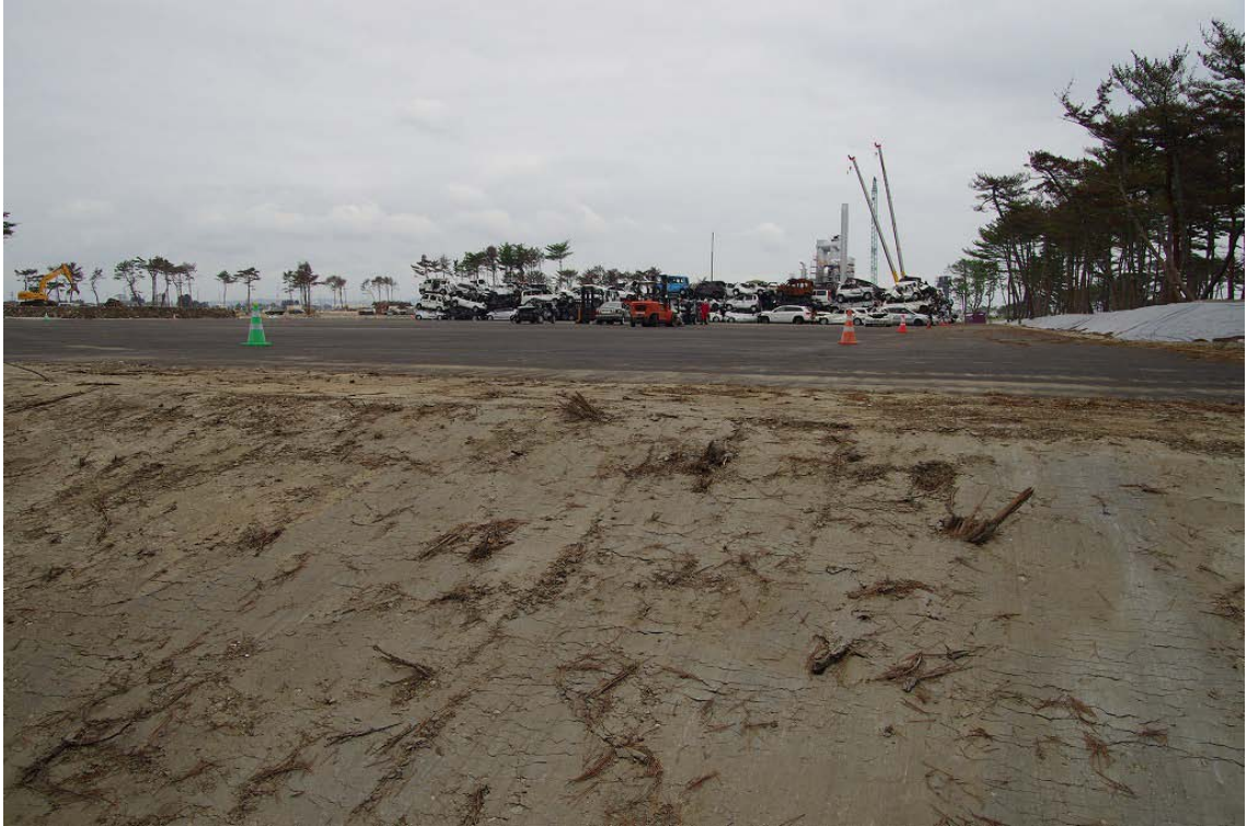
残存マツ林隣接地に接して建設されたガレキ処理場
