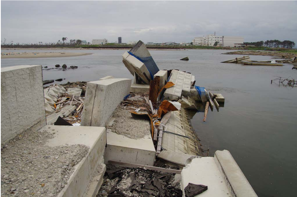
破壊された蒲生干潟南部のえん堤。
