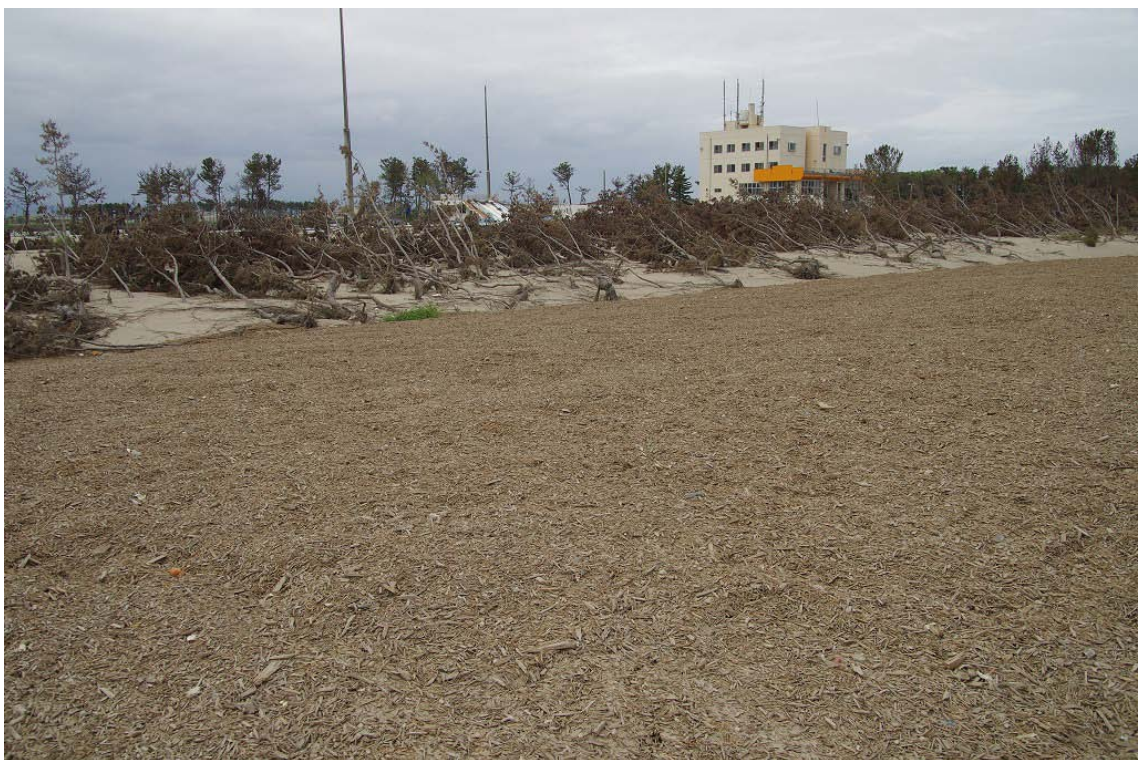
木製のガレキがチップ化されて、マツ林に隣接する砂浜の埋め立てに使われている（閑上）。
