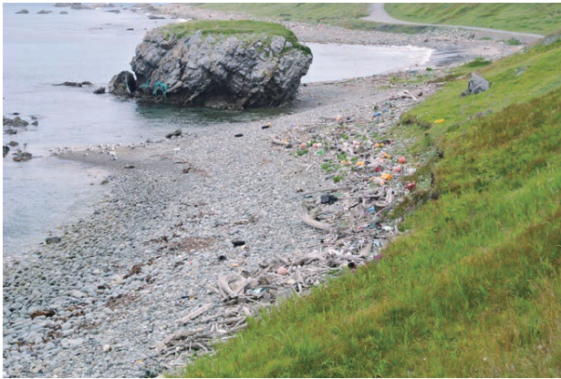
写真 3 海崖斜面下部の浸食。(尻屋崎, 2012.8.9)
