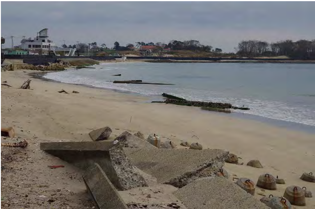
図 4 . 大谷海岸 . 2011 年 10 月 28 日の状況 . ガレキや枯死したマツは取り払われている . 遠方に黒く延びているのは礫を入れた袋を積み上げた仮設の堤防 .
