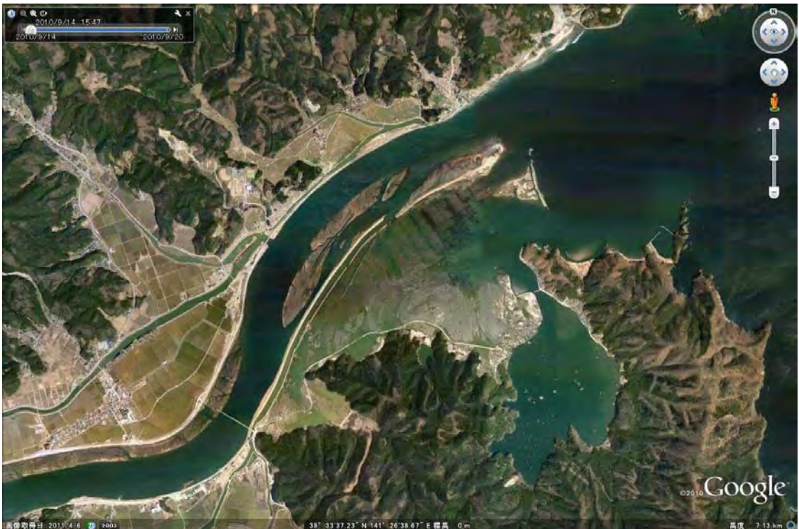
図 20．北上川（追波川）河口の被災前の地勢図（上側）と被災後の衛星写真（下側）．長面にあった砂浜とマツ林が完全に失われ，水田や集落も水没した．衛星写真は 2011 年 4 月 6 日の撮影．2011 年 10 月 28 日時点では，川の中州の消失もさらに進行していた．
