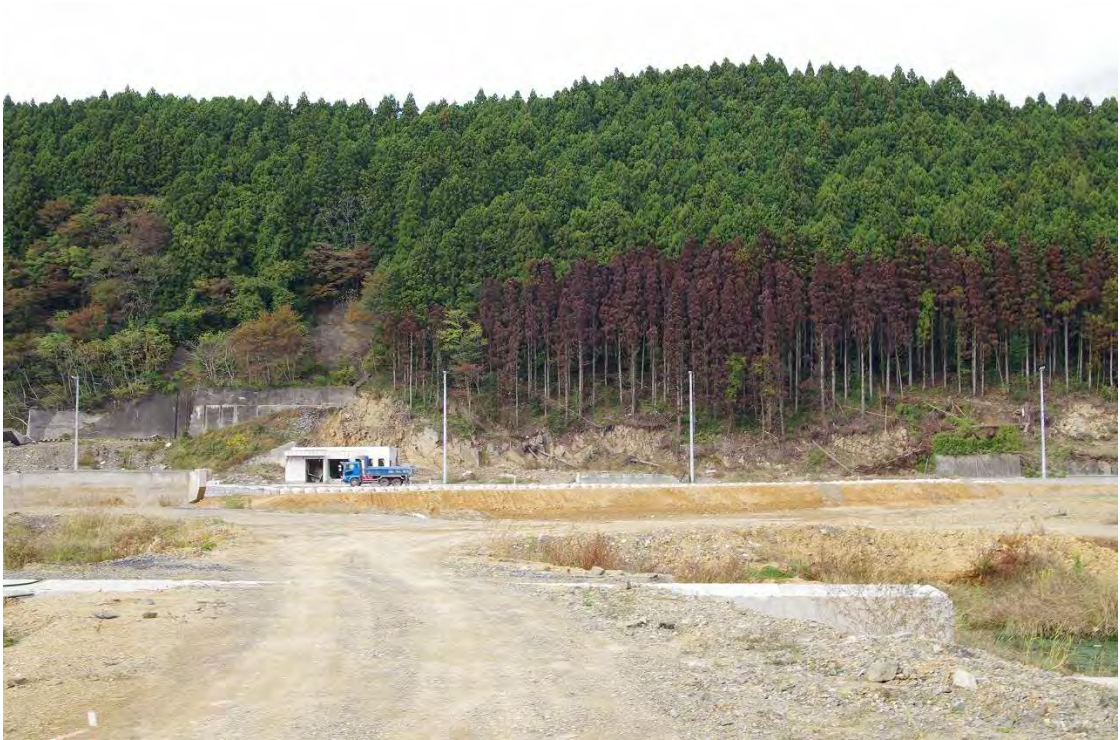
図 16．南三陸町戸倉付近のスギの枯死．右側が海方向．斜面のすぐ下の道路走るダンプカーと比べると，道路面上 15m 付近まで海水に浸かり、スギが枯死したと思われる．
