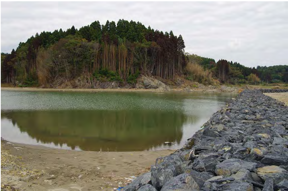
図 13 . 小泉海岸 ( 赤崎海岸 ) . 右側が海 . 仮設の堤防が設置されている . 仮設堤防の左側は水田が広がっていたと思われるが水没している .
